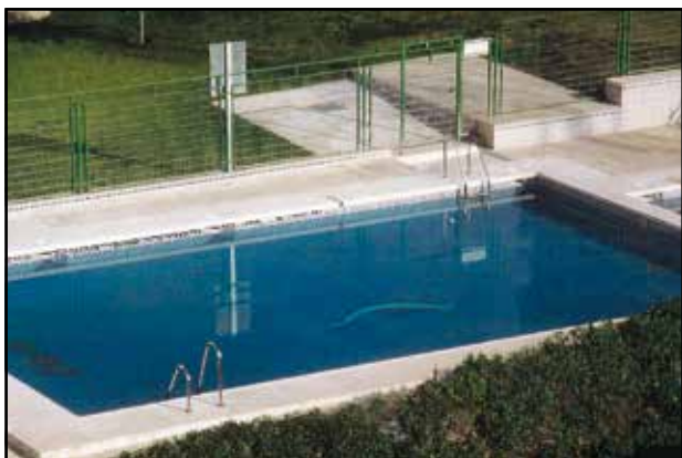
Schwimmbad mit WELLAN® 2000
