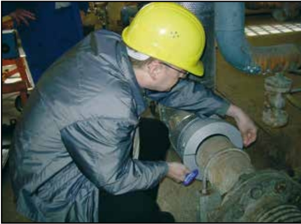
Montage eines 8" Rings an einer Industrieanlage
